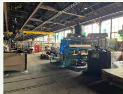
98. Structure d'acier de type Fink
