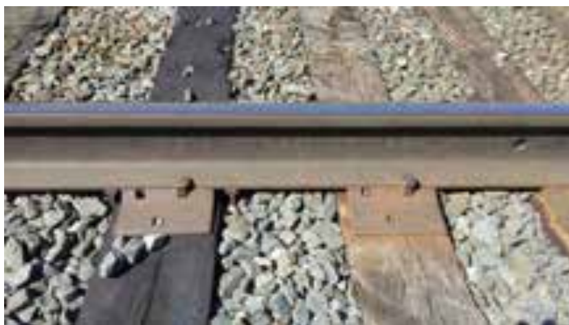
Photo 3 – Type de rail et traverses sur les voies principales du CP
