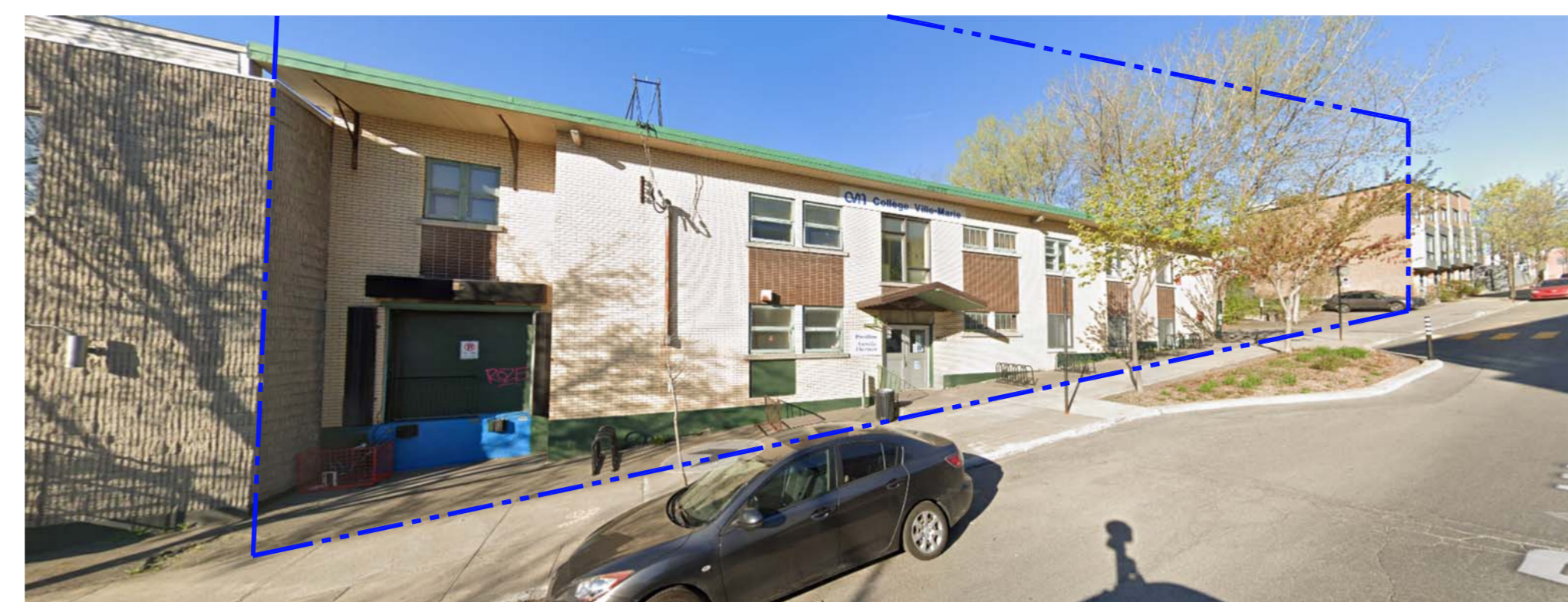
3 BÂTIMENT EXISTANT - CÔTÉ EST
