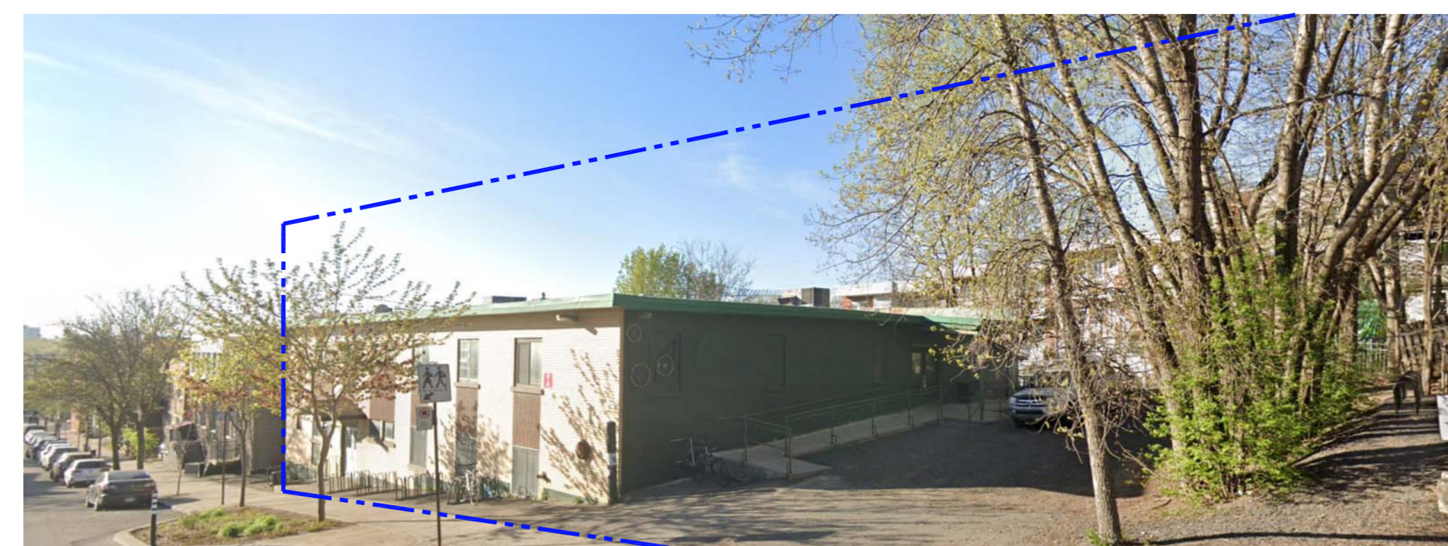
2 BÂTIMENT EXISTANT - CÔTÉ OUEST
