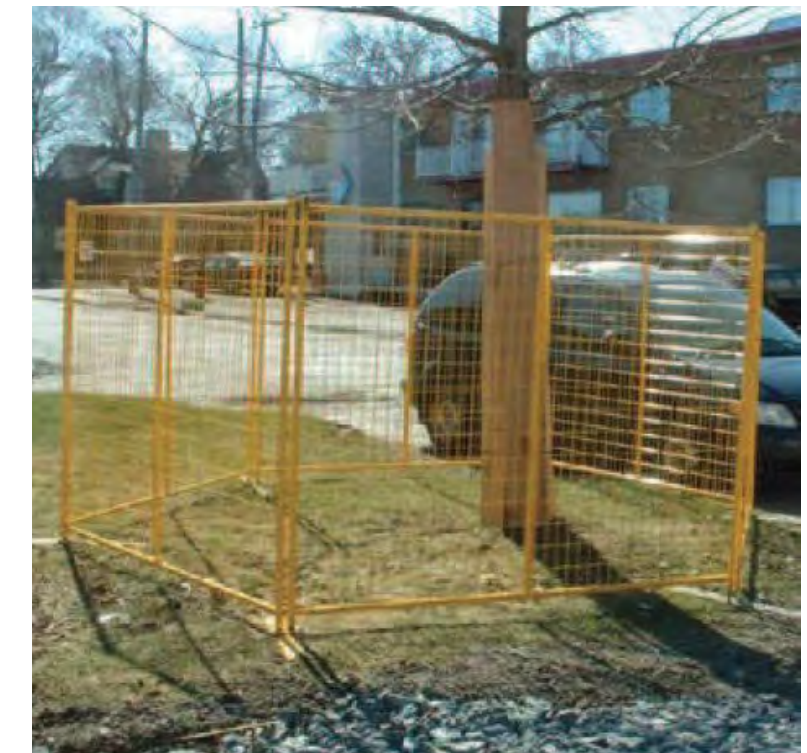
CLÔTURE INSTALLÉE À 1.2. M AUTOUR DE L'ARBRE
