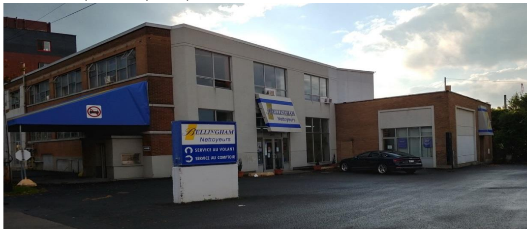
Photo 2. Façade du bâtiment existant à démolir.
