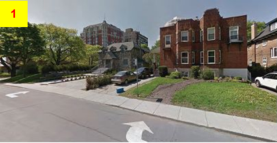
604 AVENUE VICTORIA. Insertion urbaine vers le sud.
