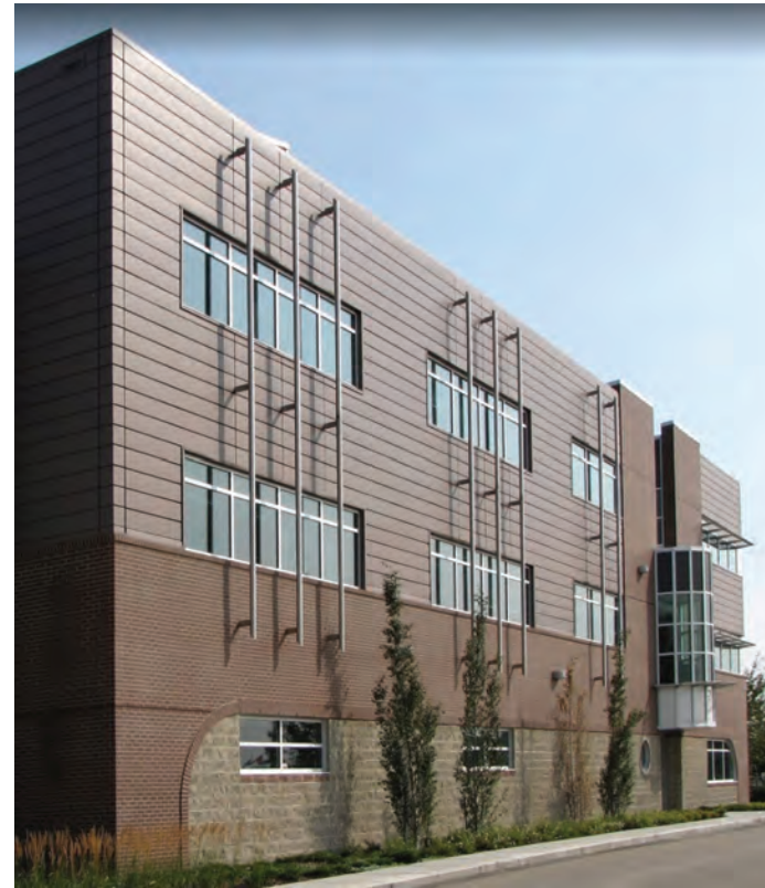
Alberta Pipe Trades College, Edmonton Année de réalisation: +/- 2005
