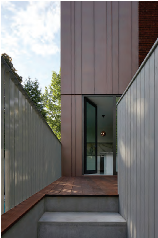
Projet résidentiel, Outremont, Québec (Pose joints pincés) Année de réalisation: 2014 - 2015
