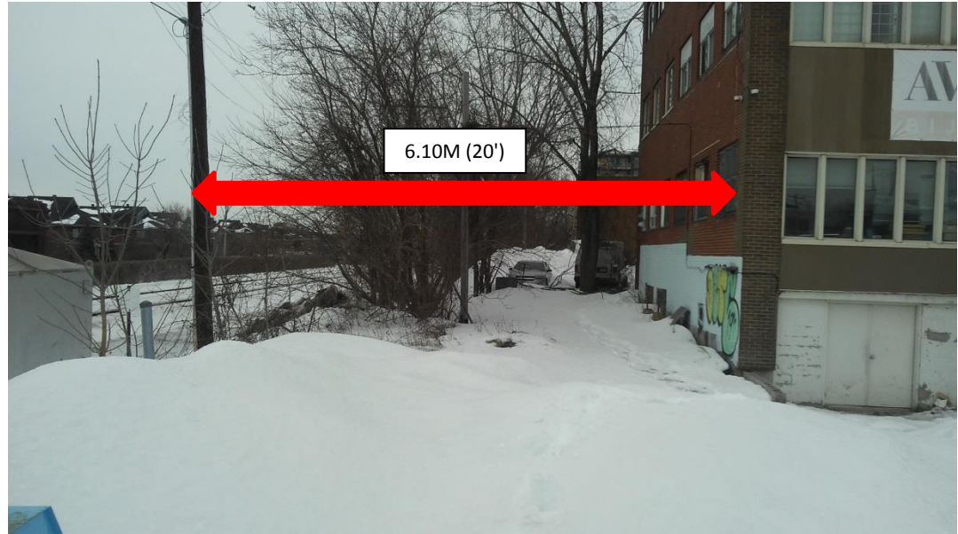
Photo 2. Arrière du bâtiment existant à démolir avec voies ferrées du Canadien Pacifique.
