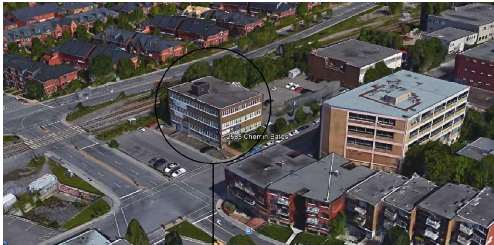
Photo 1. Bâtiments existants du 2585 Chemin Bates à démolir (PM 48.82 ADIR).
