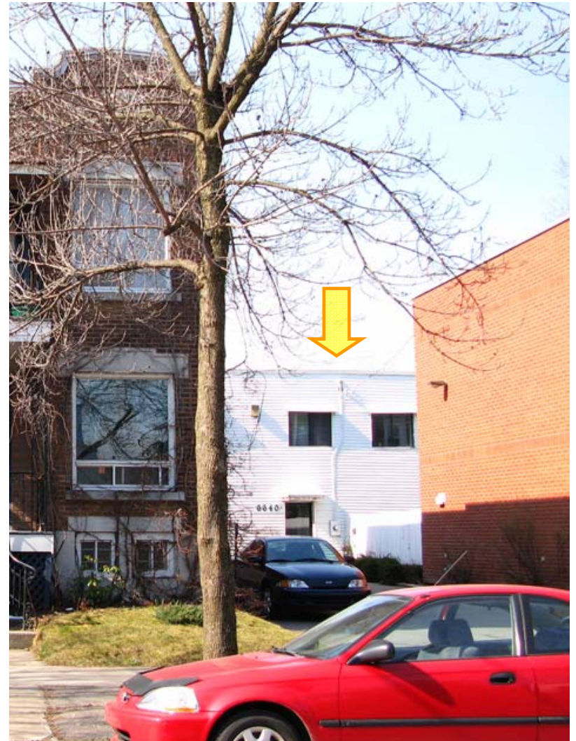
Bâtiment visé par une demande de démolition 6640A, avenue Louis-Hébert
