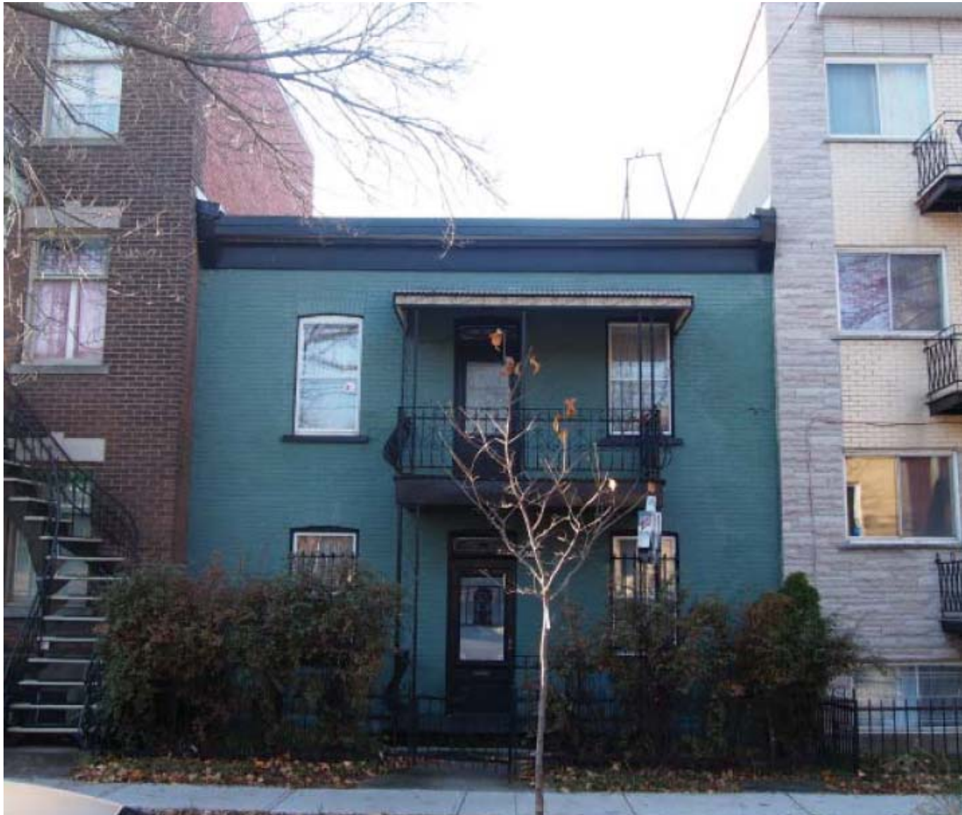
Bâtiment visé par une demande de démolition 6672, avenue De Gaspé
