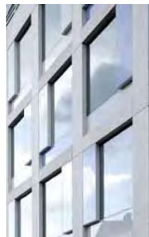
Façade en béton préfabriqué, animée avec des motifs opaques et vitrés.
