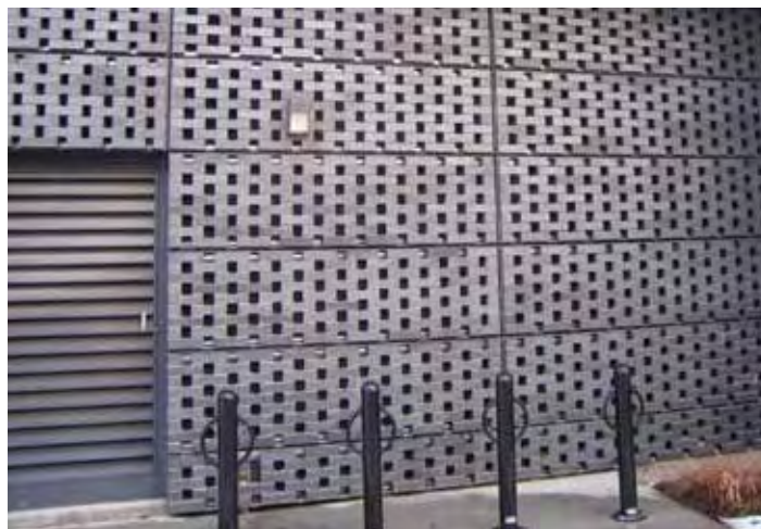
Claustra de briques servant à éclipser l'équipement technique.
