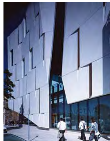
Façade en béton préfabriqué, animée avec des motifs opaques et vitrés.
