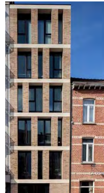
Soulignement de la dalle horizontale par un matériau contrastant. Fenêtre en retrait pour créer une épaisseur et texture.
