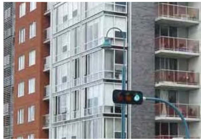
Module de fenêtre «hauteur d'étage»
