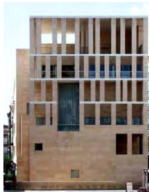
Soulignement de la dalle horizontale par un matériau contrastant. Fenêtre en retrait pour créer une épaisseur et texture.
