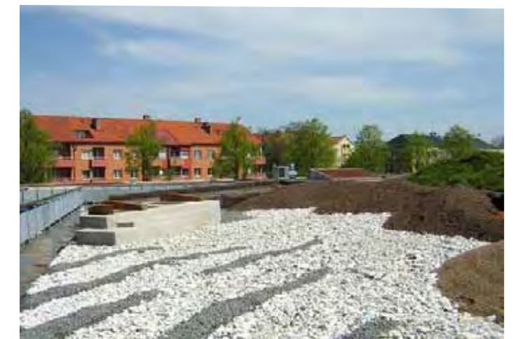
Combinaison de gravier et aménagement de l'espace.
