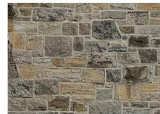
Maçonnerie existante : Granit américain Moellons, face éclatée, appareillage à dames
