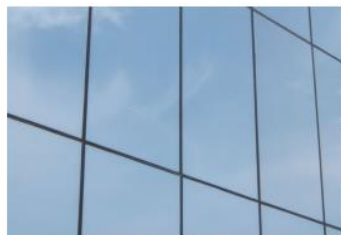
Mur-rideau en aluminium anodisé clair unité scellée, verre double avec pellicule low-E, joint silicone 4 faces
