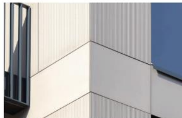
Parement en panneaux de béton léger 1 220 x 3 000 mm, Equitone linea LT90
