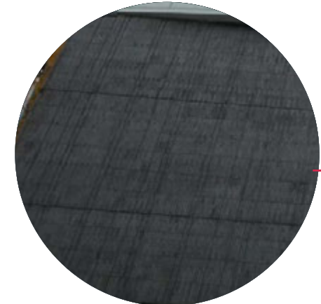
Maçonnerie de brique couleur gris-manganèse telle que Pavillon 2018
