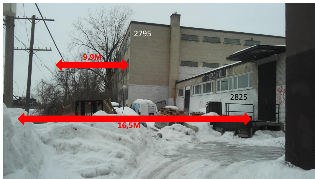
Photo 2. Arrière du bâtiment existant à démolir.
