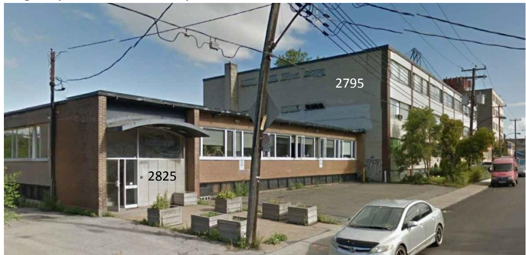
Photo 1. Façade des bâtiments existants du 2825 & 2795 Ch. Bates à démolir.
