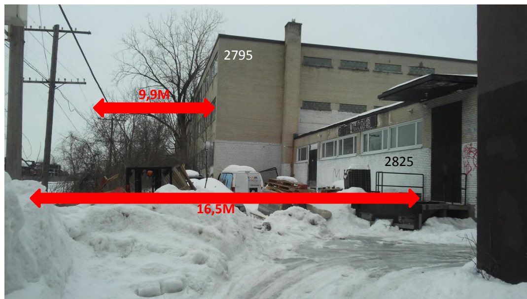
Photo 2. Arrière du bâtiment existant à démolir.
