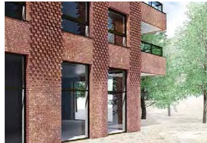
Garde-corps en maçonnerie, aluminium et verre
