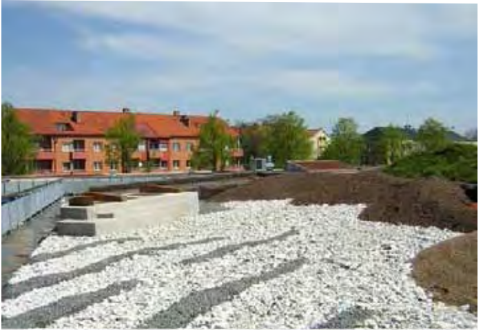
Combinaison de gravier et aménagement de l'espace.
