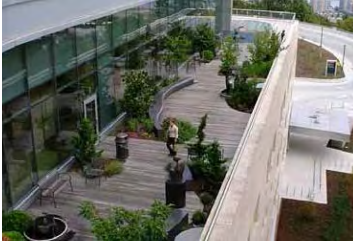
Cohérence d'aménagement pour l'ensemble de la toiture
