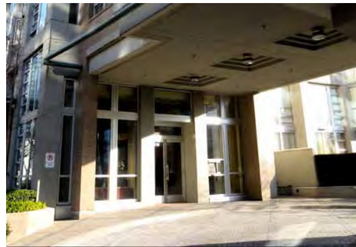
Entrée logement collectif : espace couvert facilement identifiable
