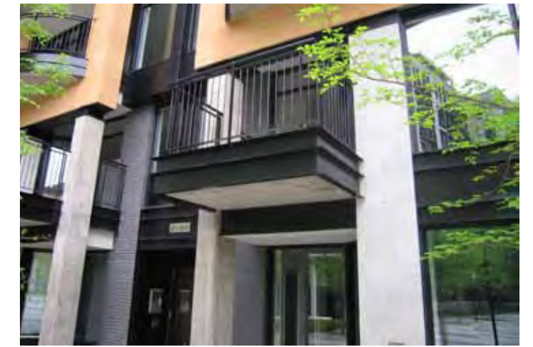
Garde-corps en barreaux
