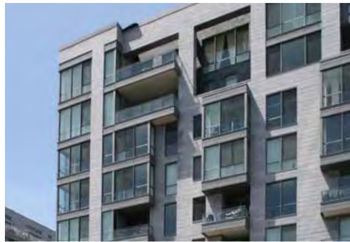
Fenestration de coin à "hauteur d'étage".
