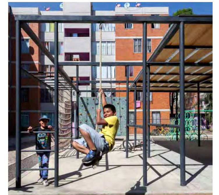
Structure hybride pouvant servir à des fins de sport. Common unity residential /
