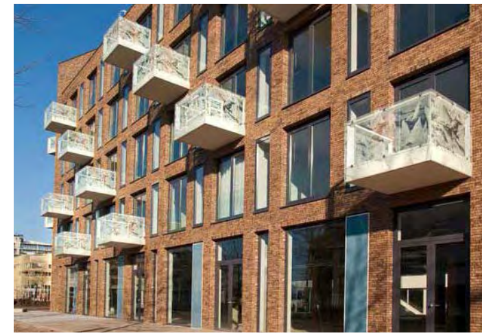
Garde-corps en verre sérigraphié et traitement de la sous-face
