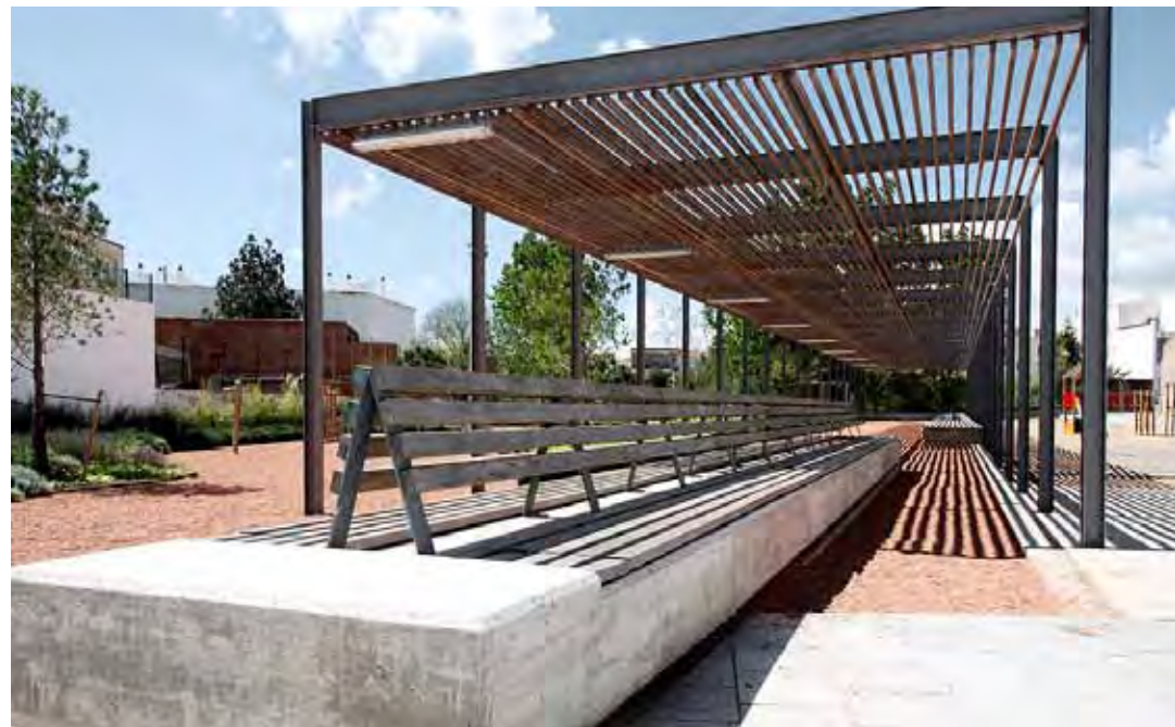
Structure ajourée et mobilier intégré. Parc Maria Martori. Tarragona, Espagne.
