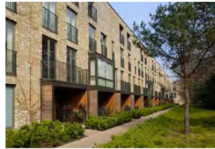
Fenestration en rez-de-chaussée.
