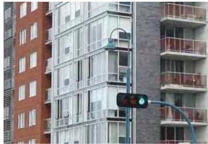
Module de fenêtre «hauteur d'étage»
