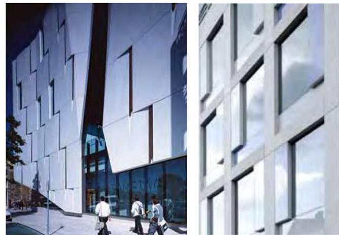
Façade en béton préfabriqué, animée avec des motifs opaques et vitrés.
