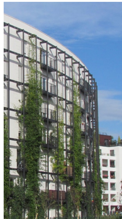
FORT D'ISSY, 329 LOGEMENTS, ISSY-LES- MOULINEAUX - FRANCE
