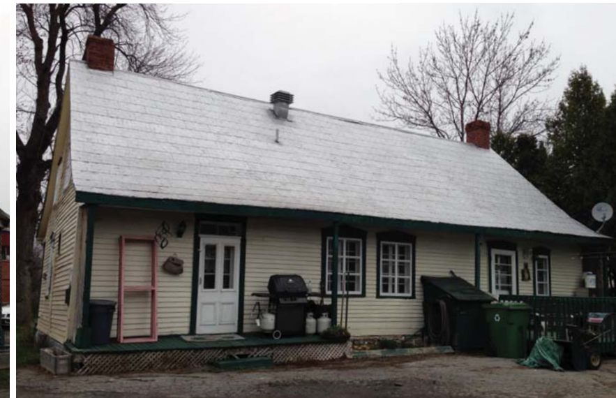
Façade arrière (côté rue Aumais) - Sud-Est
