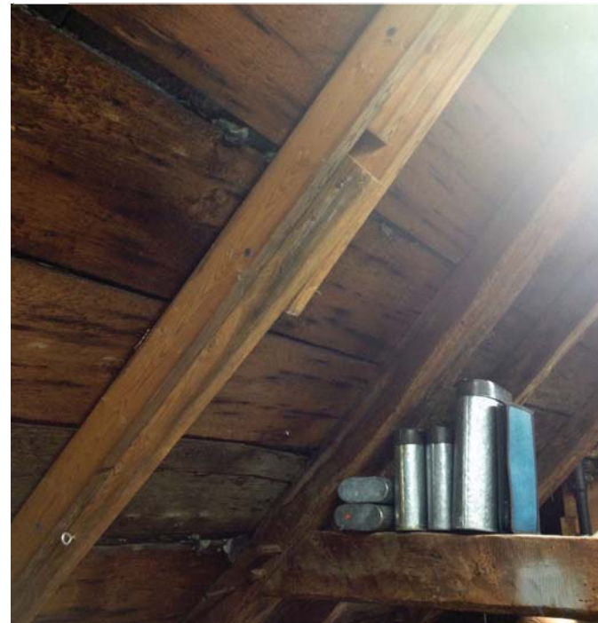
Revêtement de toiture en bois apparent
