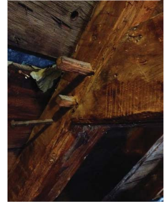
Détail de la charpente en bois d'origine
