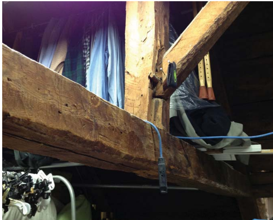
Charpente en bois d'origine
