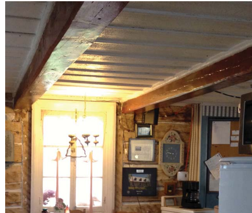
Poutres en bois entre le rez-de-chaussée et les combles
