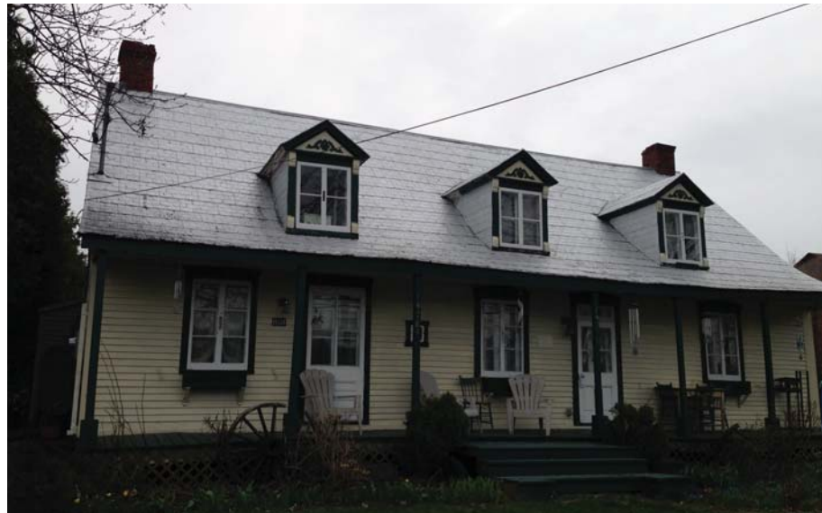
Façade avant (côté rivière) - Nord-Ouest
